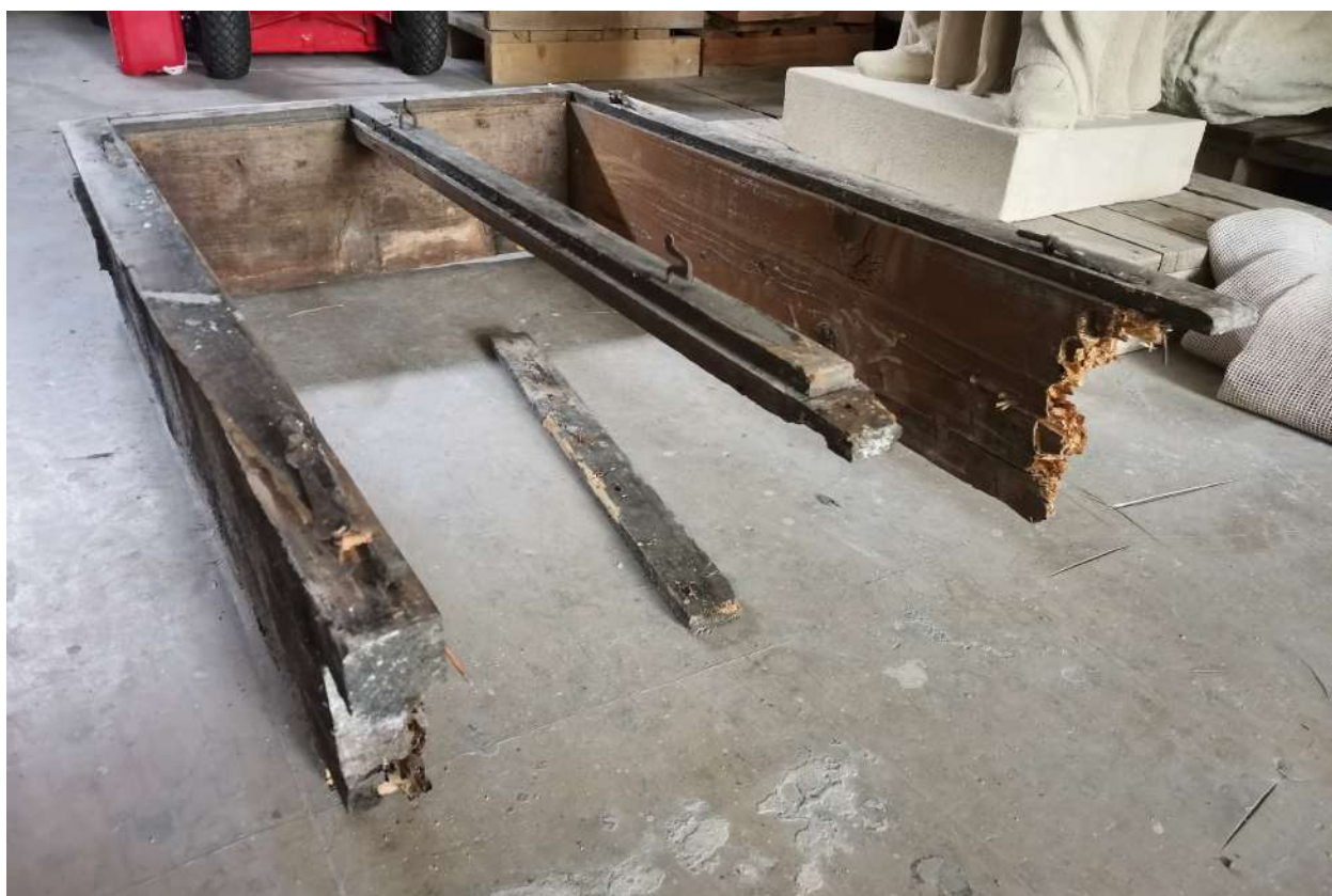
028 stav konštrukcie okna, z ktorého bolo nutné vyhotoviť kópiu
