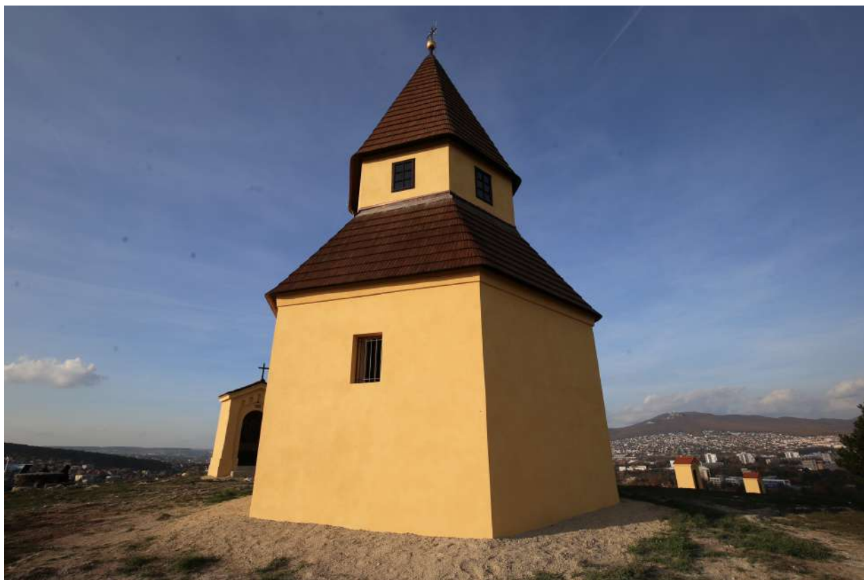
019 celok, stav po obnove
