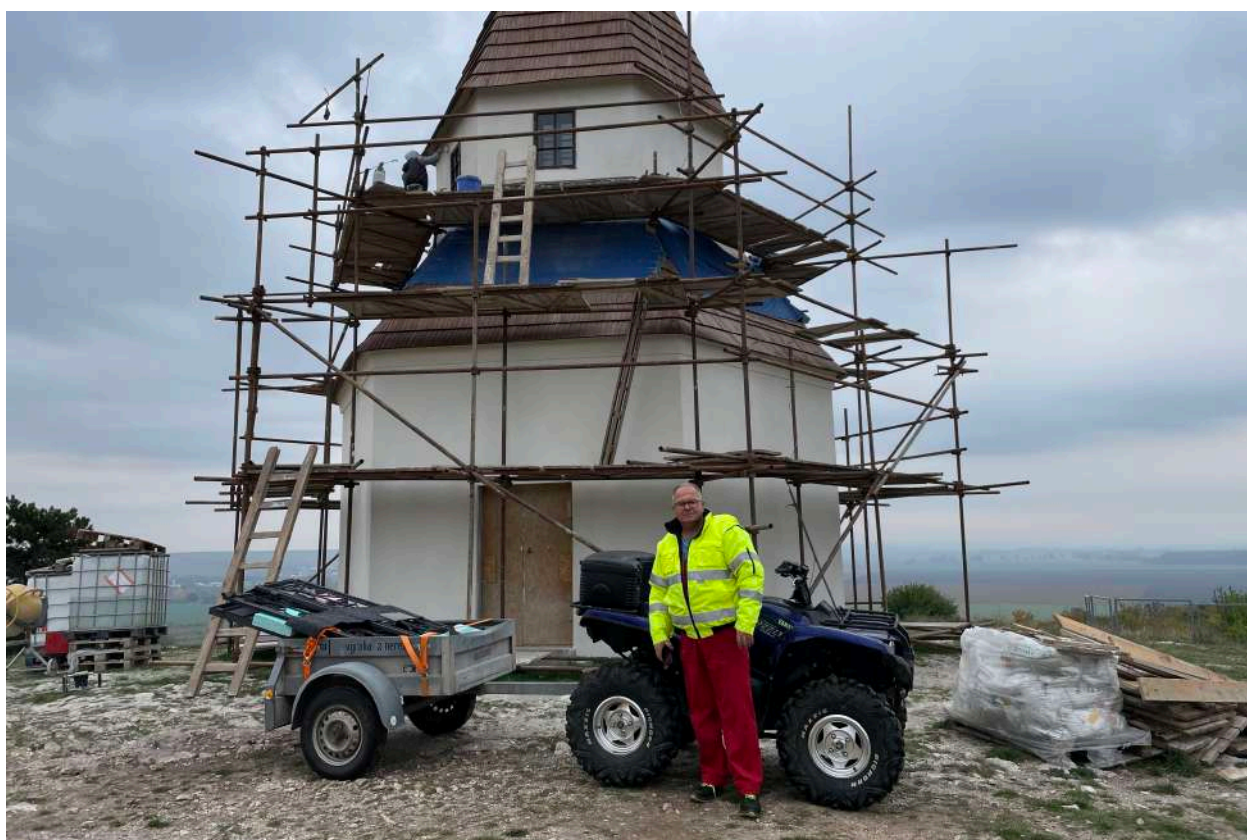
016 transport obnovených vstupných dverí a vstupných mreží
