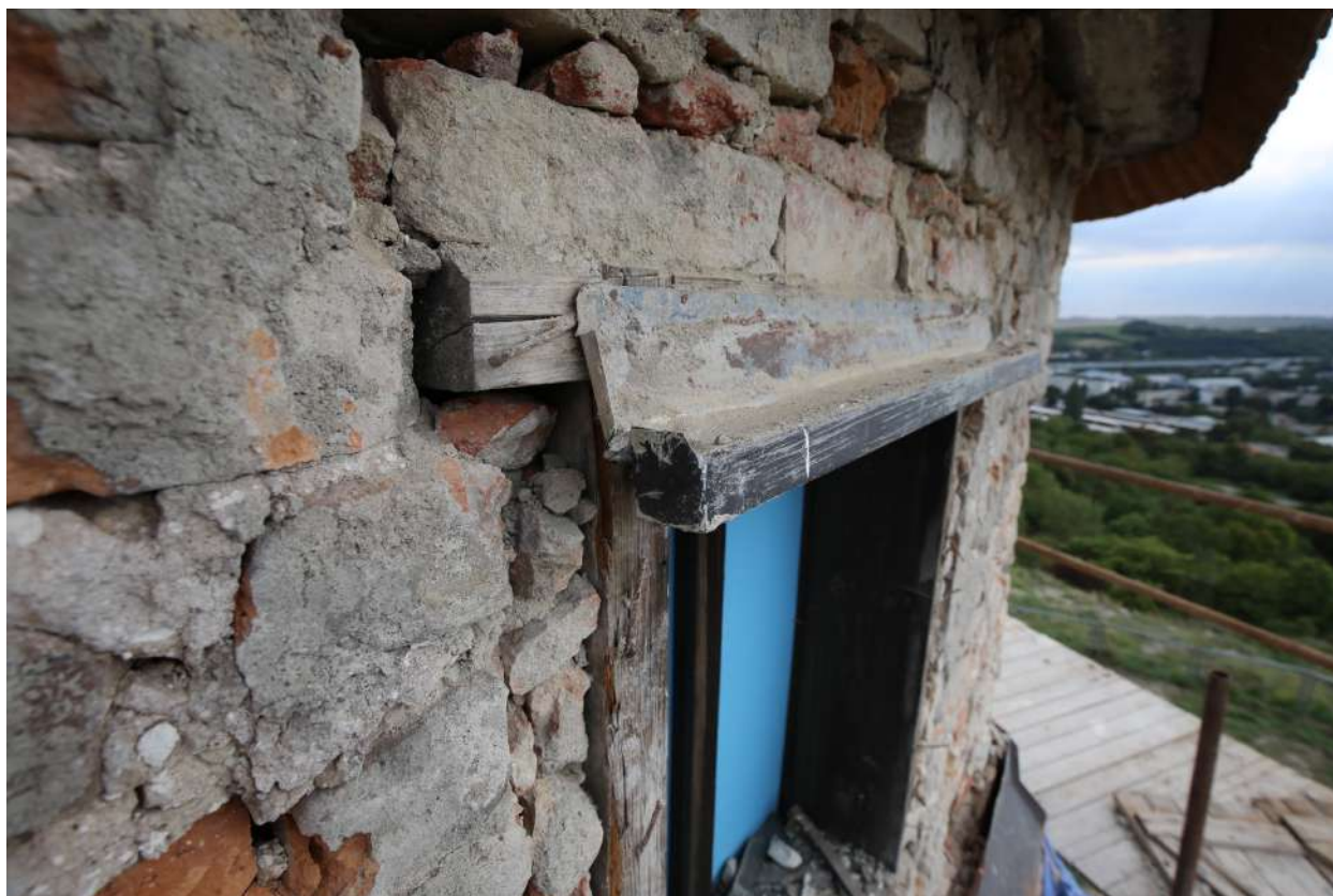
011 detail muriva laterny po odstránení cementových omietok
