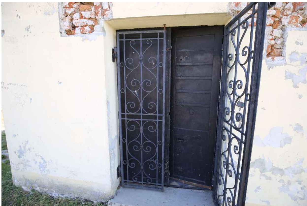
041 stav dverí a mreže pred obnovou
