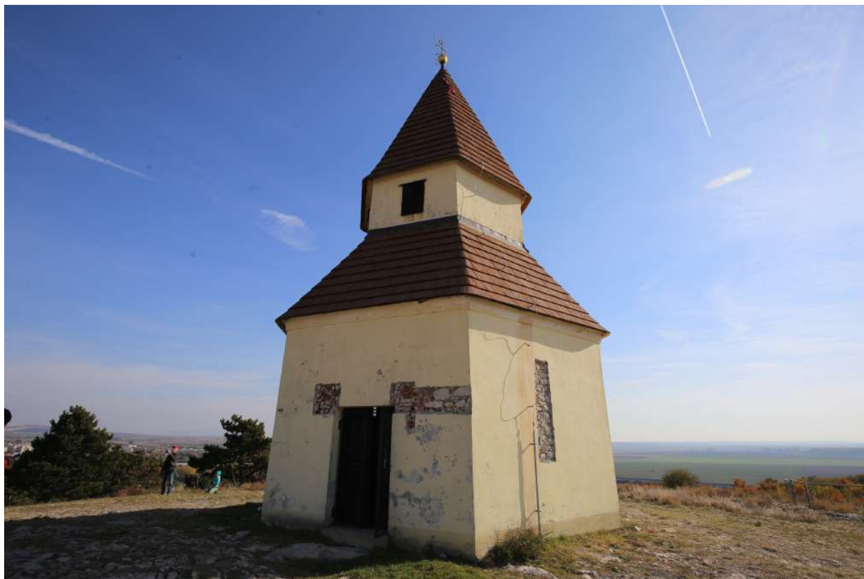
001 celok, stav pred obnovou
