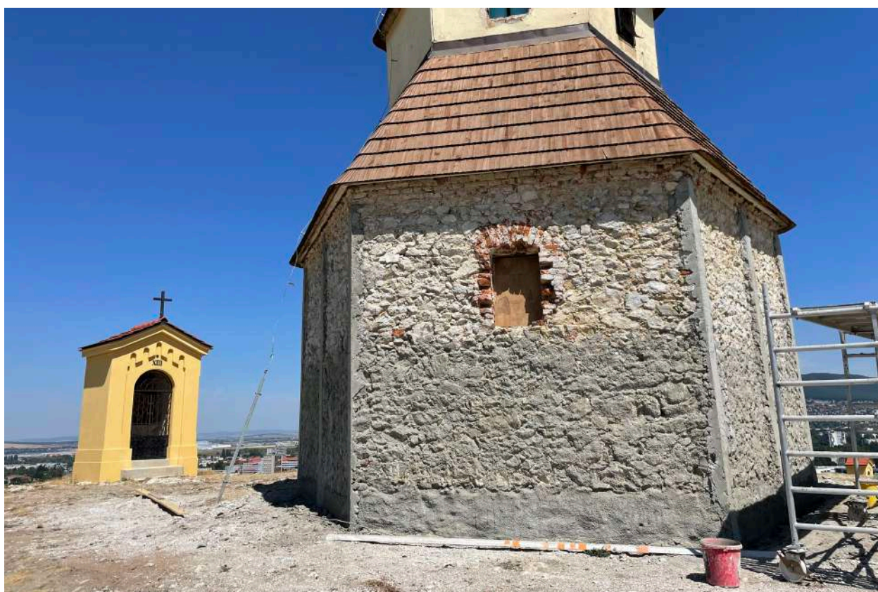
006 realizácia vodítok pre zrovnanie povrchu fasády kaplnky Božieho hrobu
