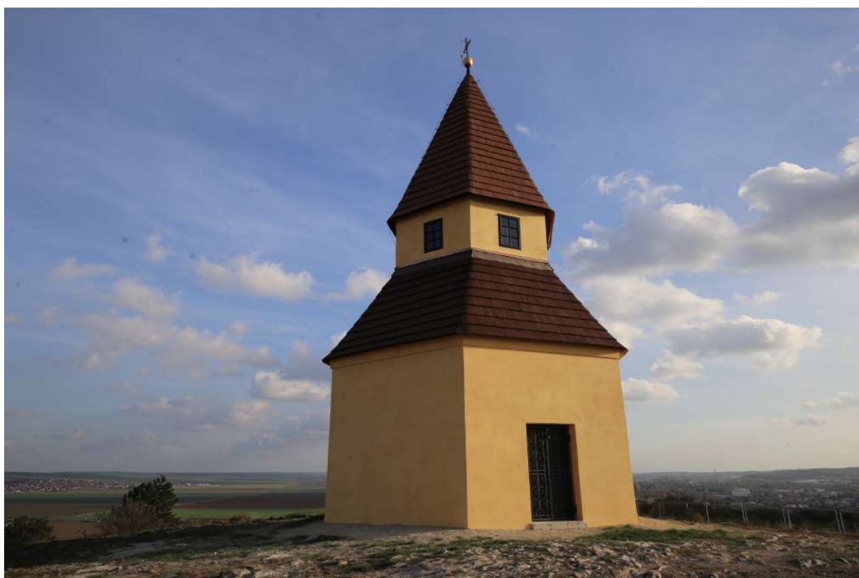
018 celok, stav po obnove
