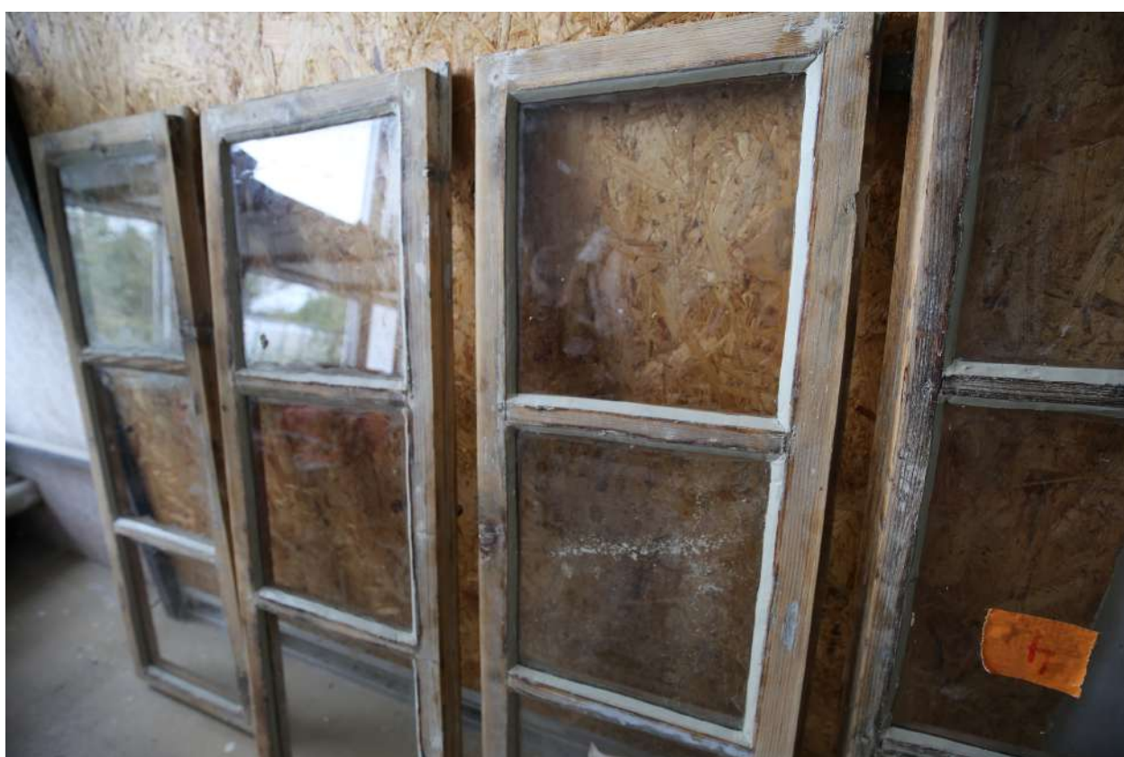
030 primárne okenné krídla po očistení od sekundárnych náterov, tmelení a novom zasklení
