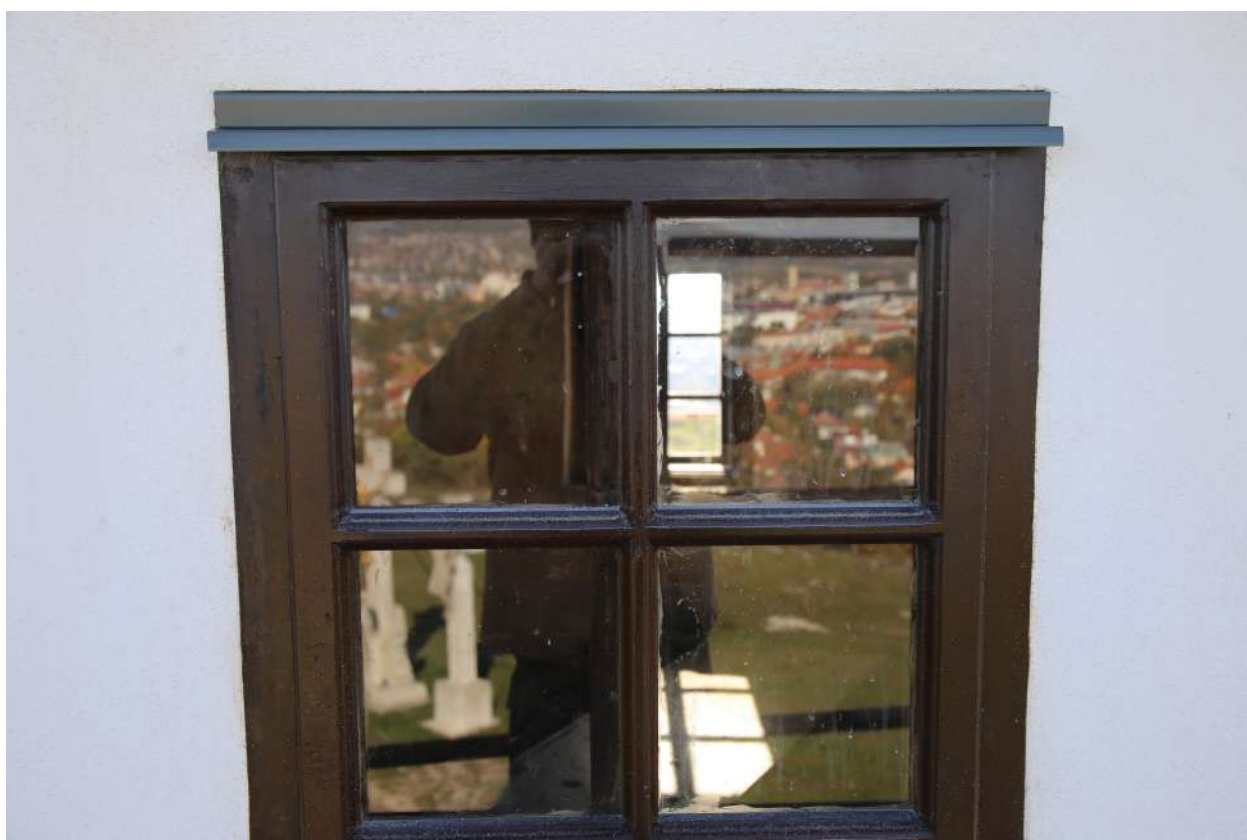
038 okno po finálnom nátery a fixácii oplechovania nad ním
