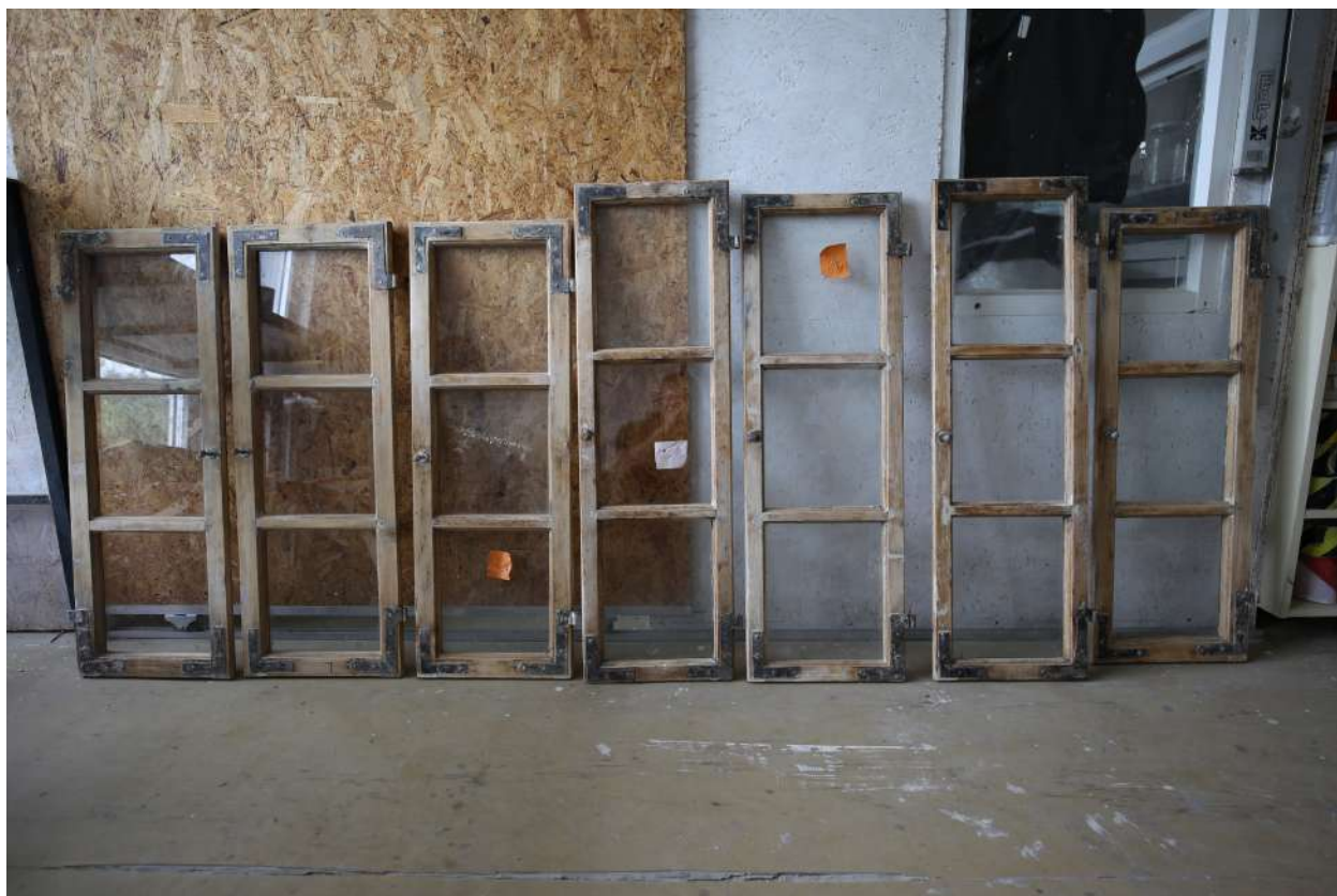
029 stav primárnych okenných krídel po ich očistení od sekundárnych náterov, tmelení a novom zasklení
