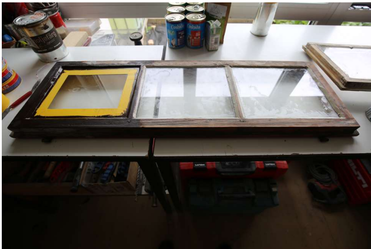
031 aplikácia nového olejového náteru na okenné krídlo
