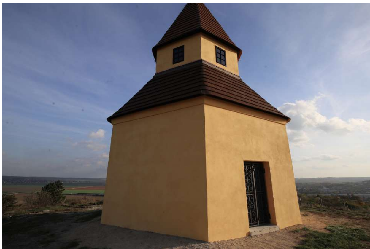
022 celok, stav po obnove
