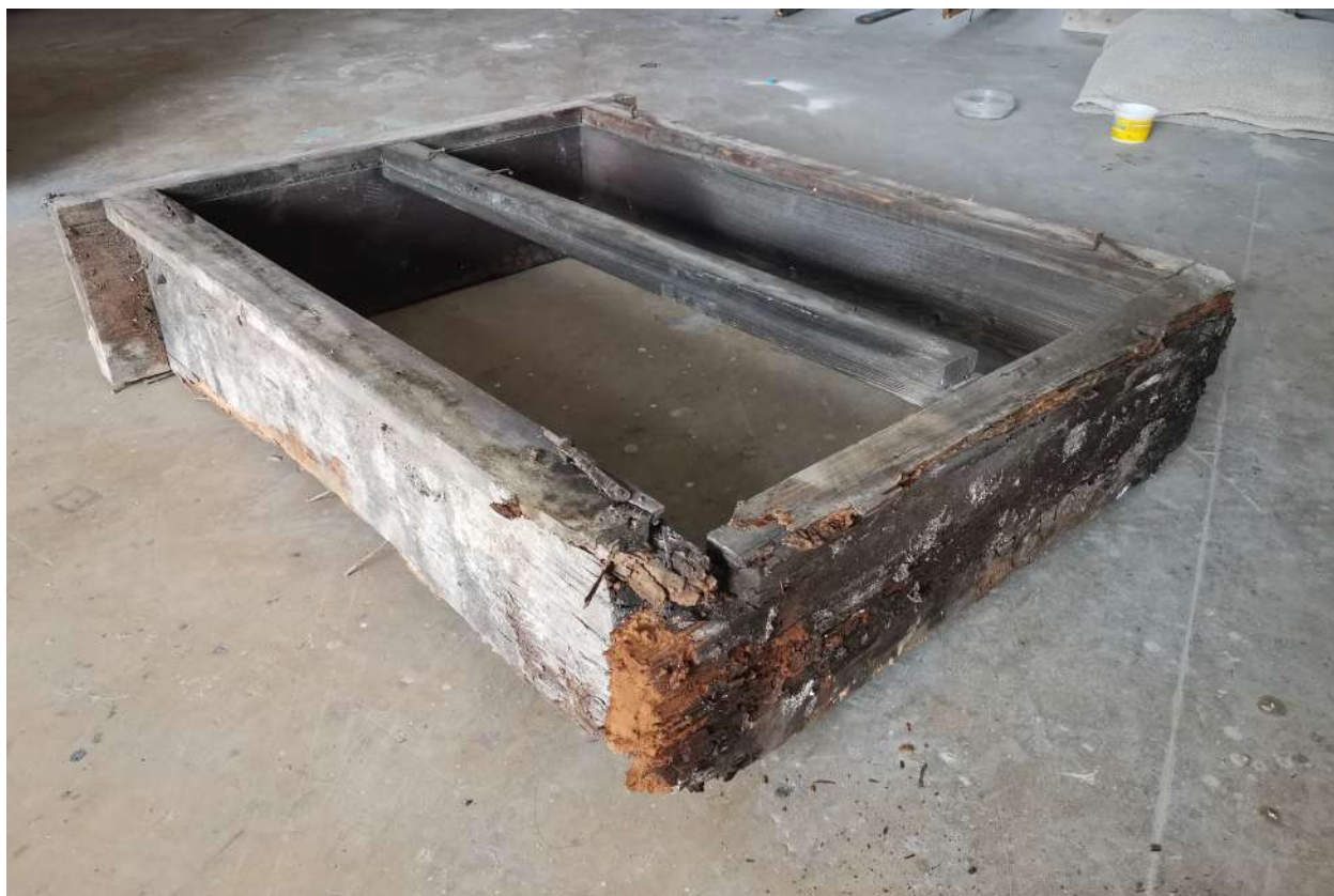
027 stav konštrukcie okna po vyňatí zo steny laterny
