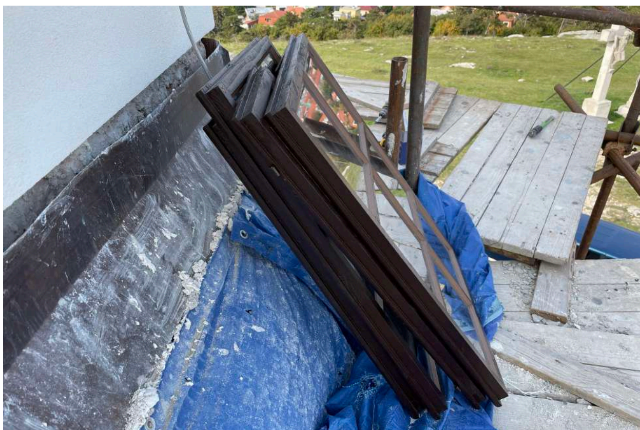
034 okná pripravení na inštaláciu na mieste
