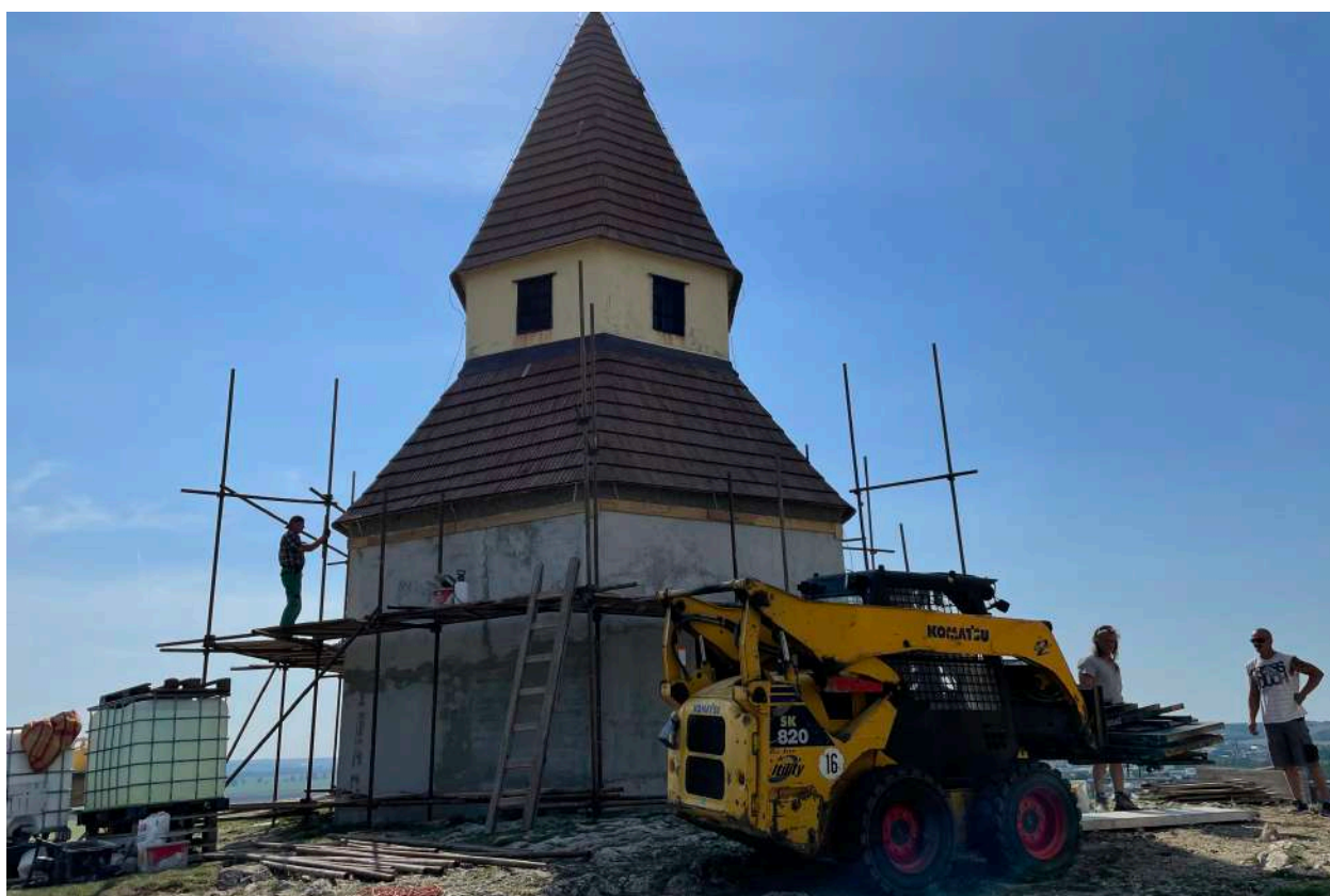
008 osadenie drevených vodítok potrebných pre tvarovanie podstrešnej rímky a transport lešenia na vrchol kalvárie
