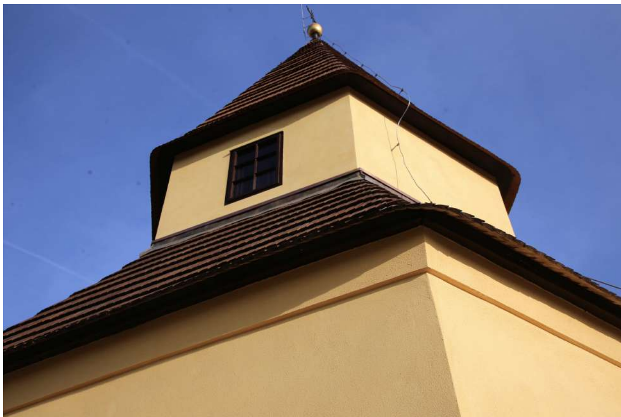
021 detail, stav po obnove
