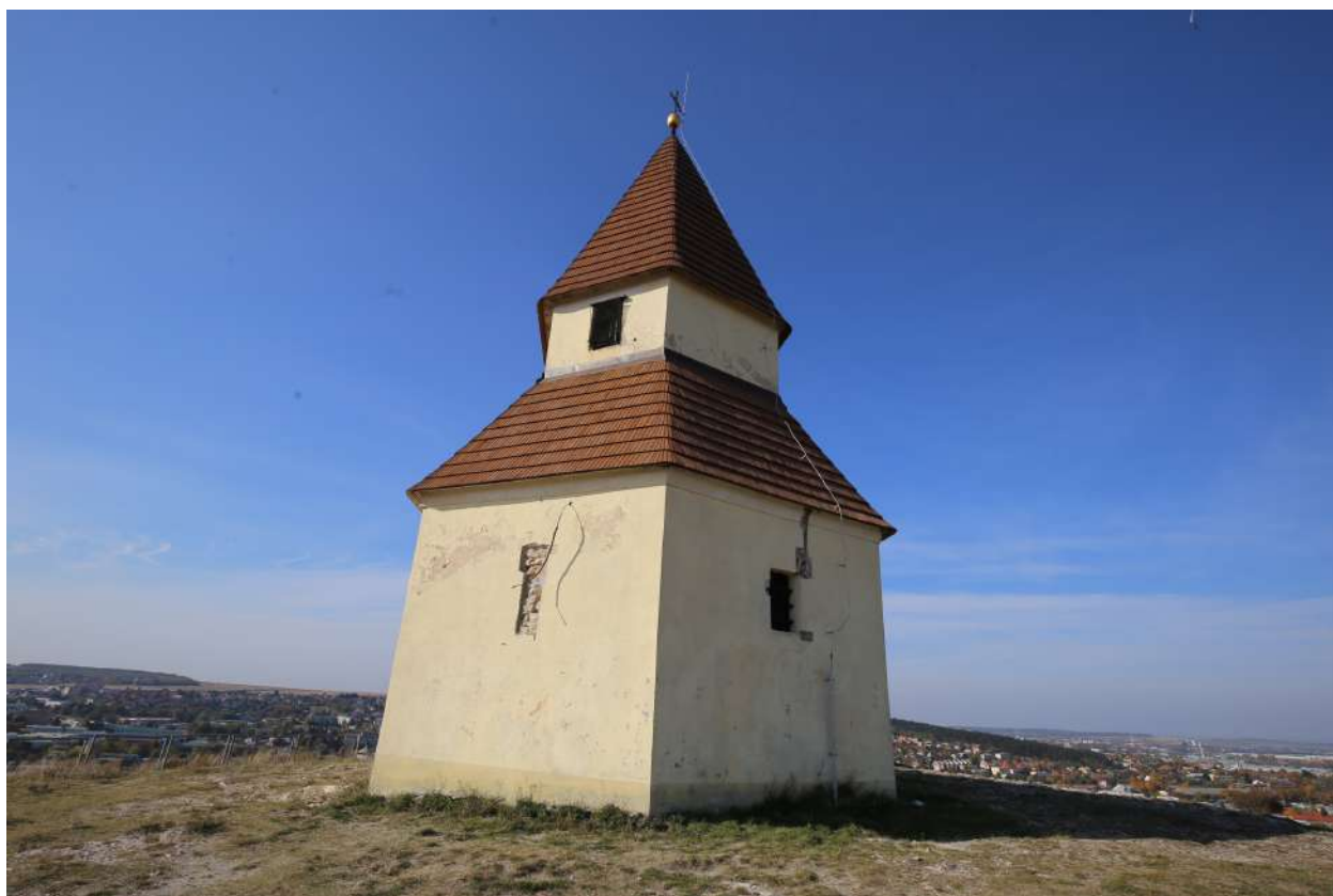
002 celok, stav pred obnovou
