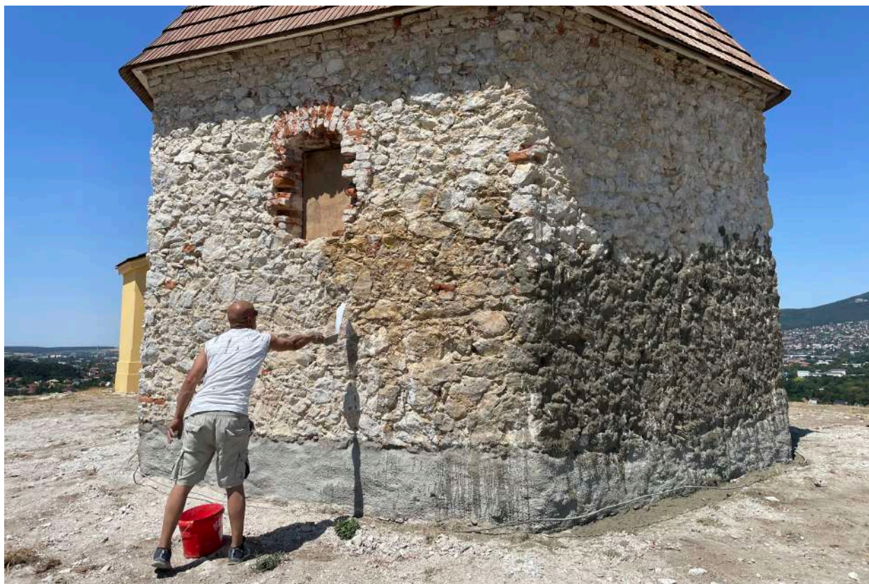
005 vlhčenie muriva a následná aplikácia špricu pre lepšiu súdržnosť nových omietok s podkladom
