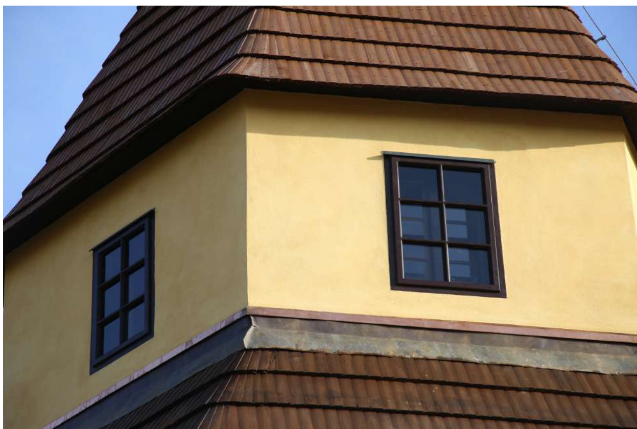
020 detail, stav po obnove
