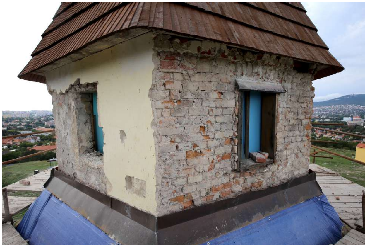
009 postupné odstraňovanie nevhodných omietok z plášťa laterny
