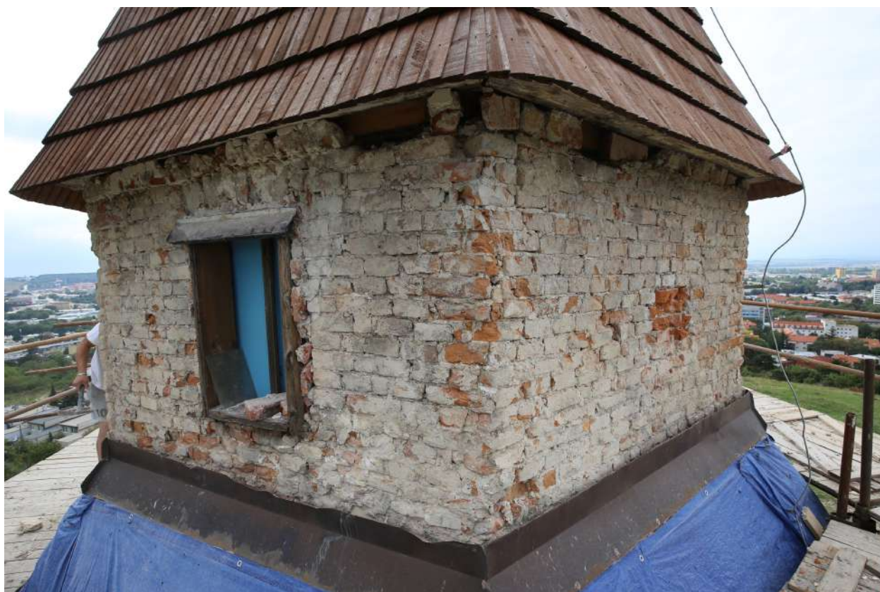
026 stav okna na fasáde po odstránení "bezpečnostnej" siete a omietok z plôch laterny
