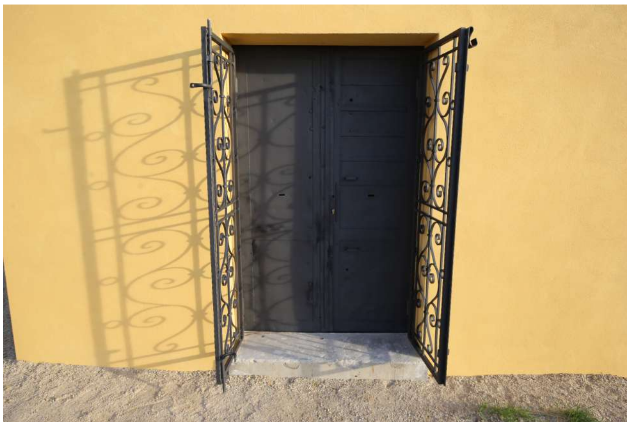
042 stav dverí a mreže po obnove
