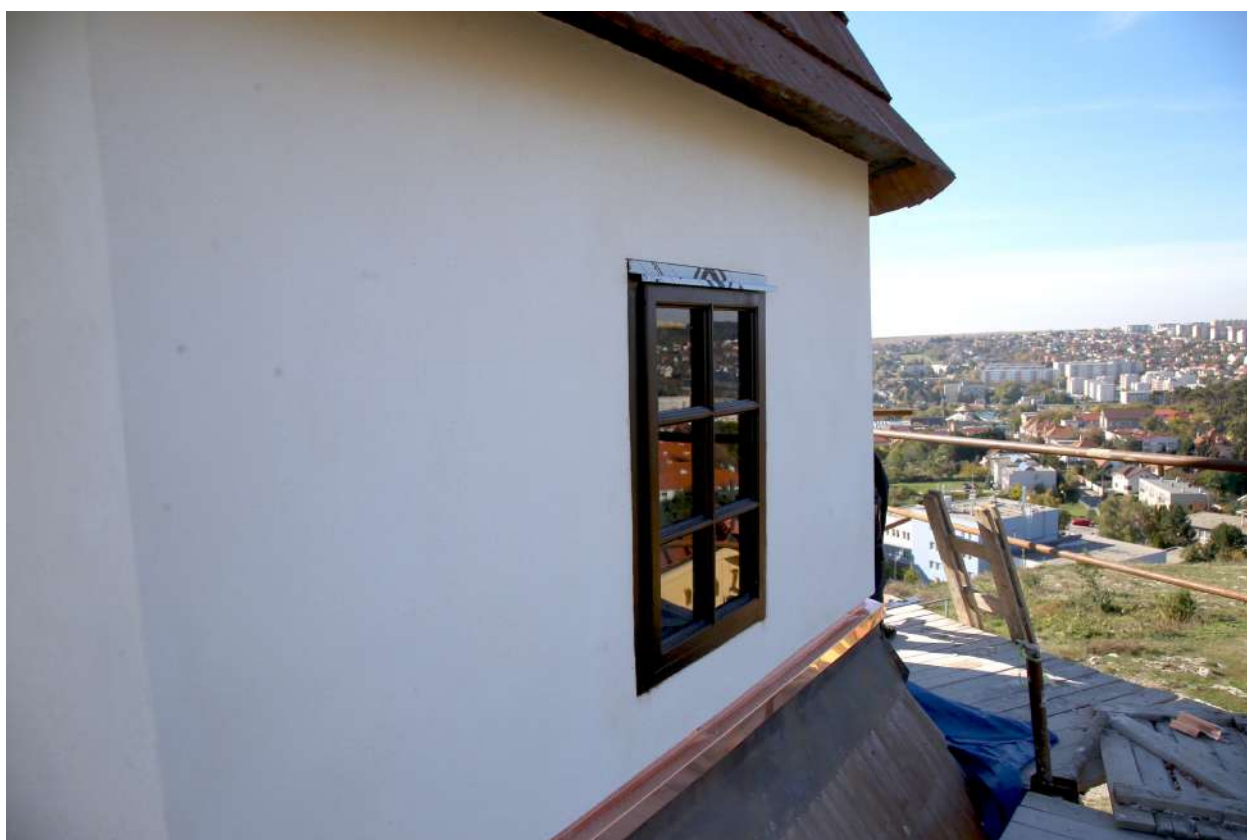
014 detail finálnej omietky a nového okna, stav po úprave a zhodnotení podbitia presahu strechy
